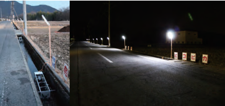
左：水路への設置（小水力サミットin岐阜） 右：防犯灯利用の様子（同左）
